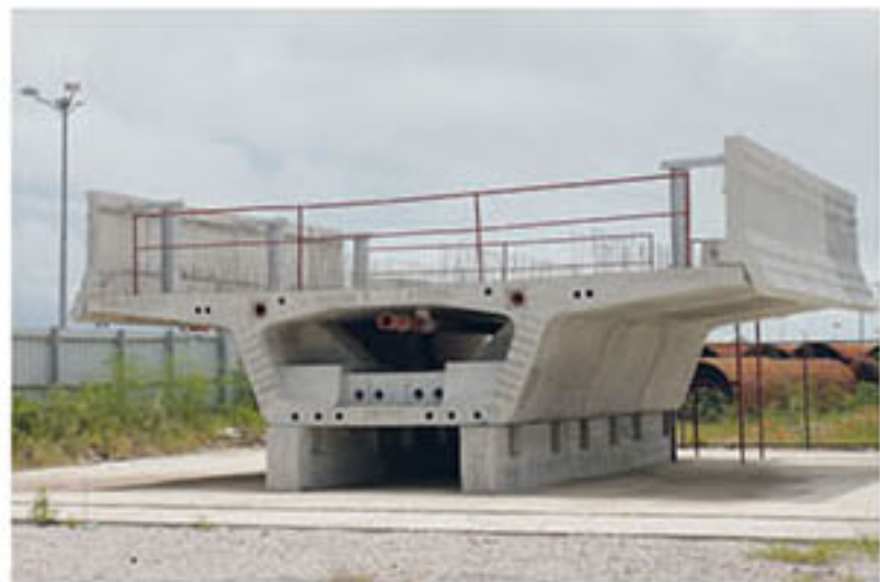
高架橋預製件樣板將作測試平台
